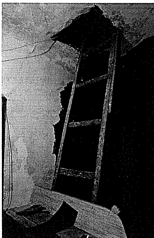
Рис. 7 Выход на крышу.
